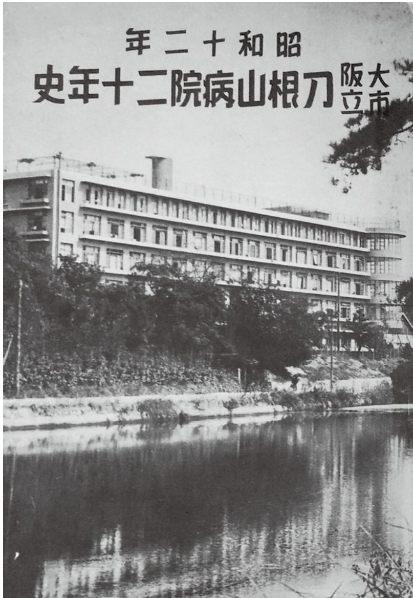
写真6 昭和12年に刊行された「大阪市立刀根山病院二十年史」の表紙。昭和9年に建設された鉄筋コンクリート5階建の新棟
